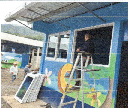
Foto 5: colocación de ventanas
