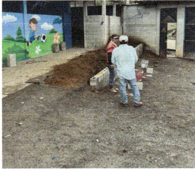
Foto1: reparación de corredor
